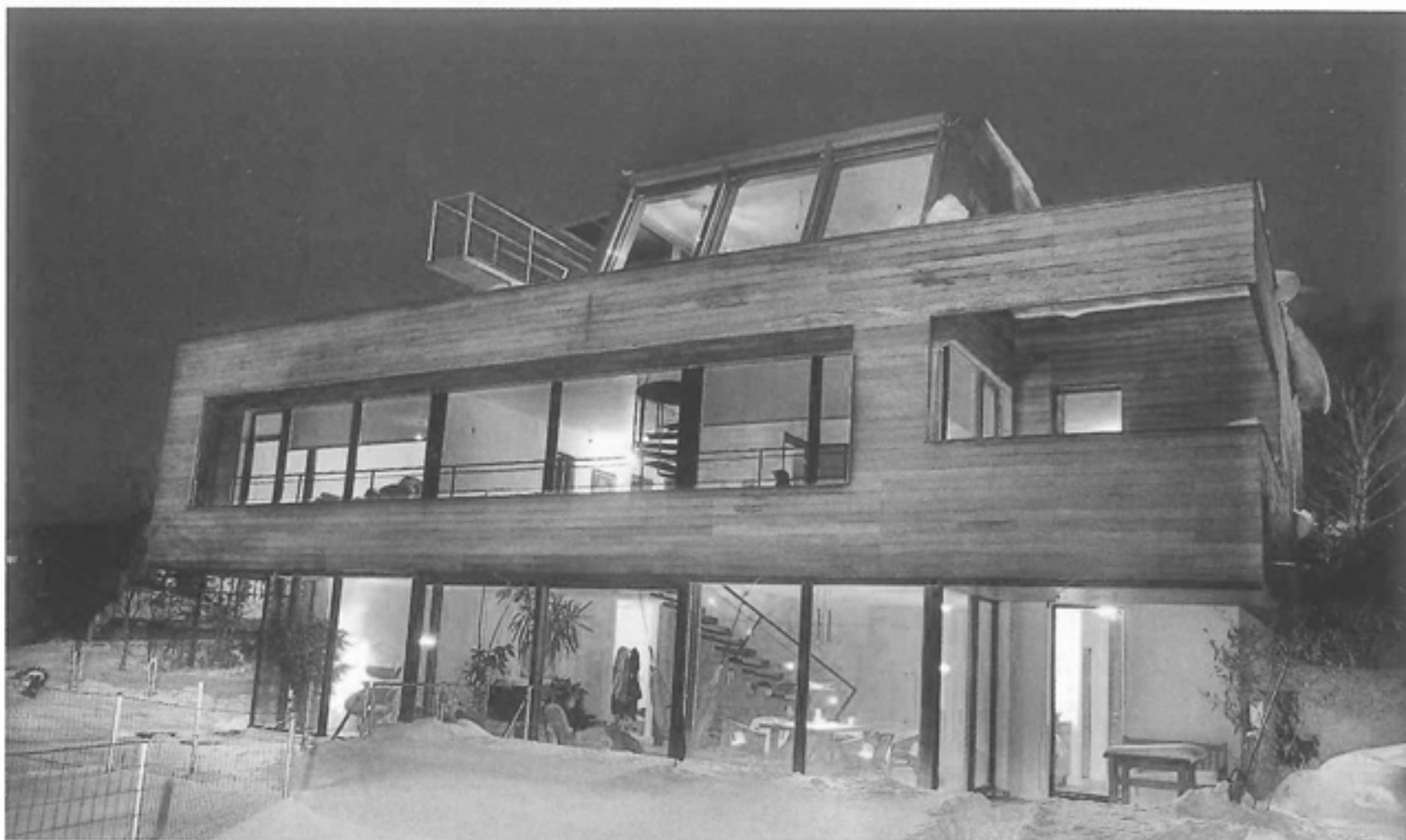
▲ ODBORNÁ POMOC. Zájemci o úsporné bydlení by si měli dát pozor na výběr stavební firmy. Některé nemají dost zkušeností. Pasivní dům ve Vídni.
